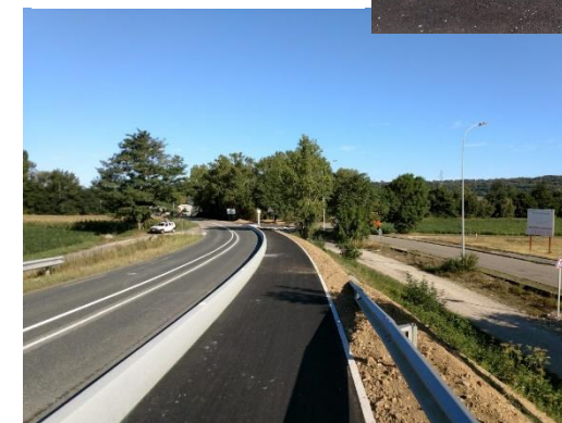
CVCB Réalisée à Saint-Maurice-de-Beynost - CCMP
