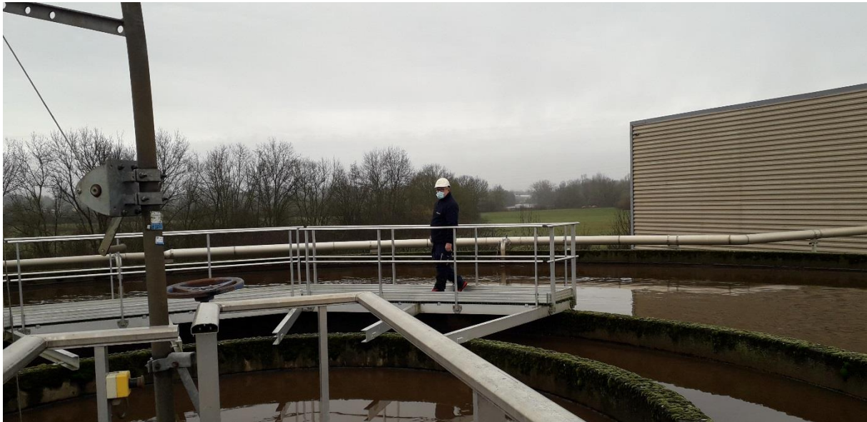
Un agent SUEZ inspecte les bassins de la station d'épuration de Louhans
